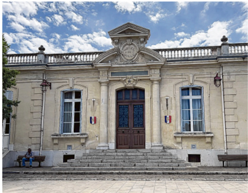
La mairie, construite en 1902, est un édifice incontournable. Le siècle précédent, Cadolive était un simple hameau de Saint-Savournin, mais jouissait déjà d'une relative autonomie. /PHOTO M.R.
